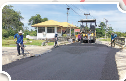
โครงการซ่อมแซมถนนปูแอสฟัลติกคอนกรีต หมู่ที่ 4 (สะพานศูนย์เด็กเล็ก-บ้านนางเอื้อน)
