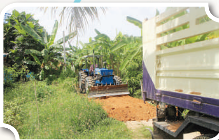
โครงการซ่อมแซมถนนถนนลูกรังกลบหลุมบ่อถนน หมู่ที่ 1 (บ้านนางสำเนียง)
