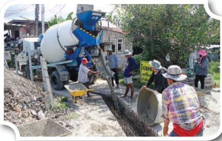
โครงการก่อสร้างรางระบายน้ำ คสล.หมู่ที่ 3 (จากบ้านนางฉะอ้อน - ศาลากลางบ้านดอนมะกอก) งบประมาณ 326,000.-บาท
