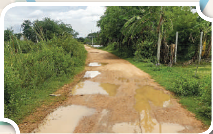
โครงการซ่อมแซมถนนถนนลูกรังกลบหลุมบ่อถนน หมู่ที่ 1 (สายเหมืองสามร้อย)
